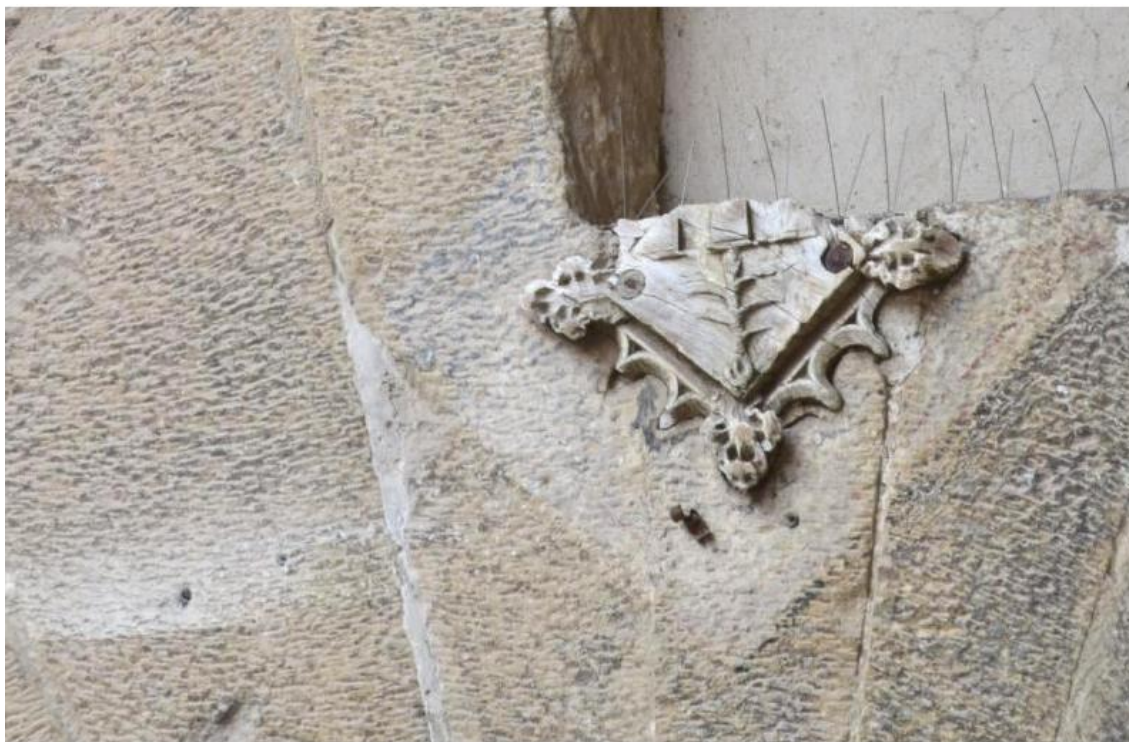
Fig. 10: Detalle del escudo de armas gótico del Concejo sobre la puerta de acceso del antiguo Consistorio, Lonja de Alcañiz.
